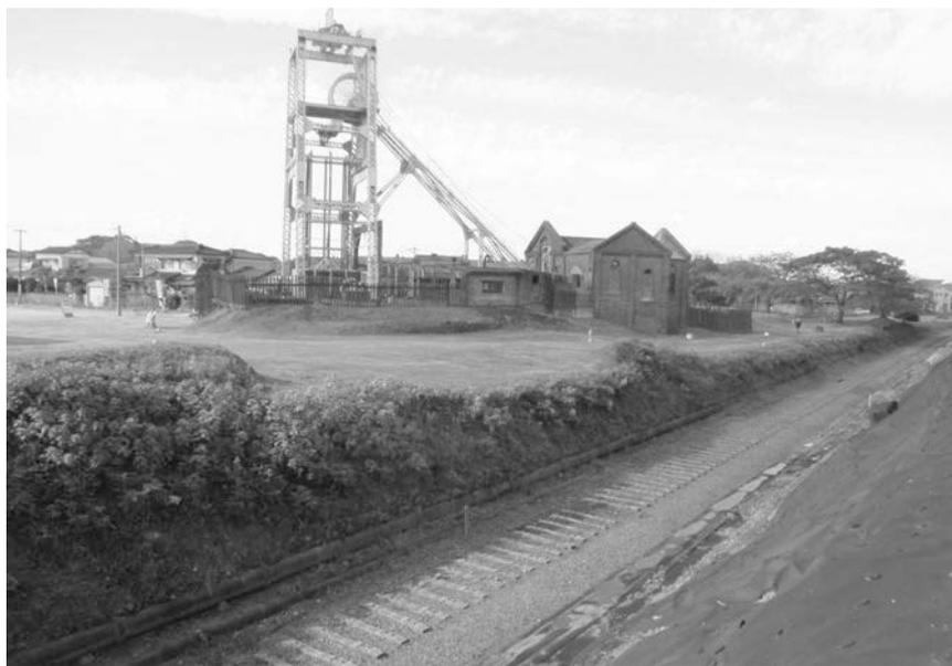
・三池炭鉱専用鉄道敷は、明治24(1891)年に開通し、最盛期には総延長150kmにも及び、石炭や炭坑資材など重い荷物を運ぶため、坂道の少ない平坦な土地に作り変え線路が敷設されています。
